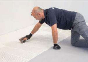
IT 2 Distribuire la colla sul pavimento utilizzando l'apposita spatola a denti inclinati (10x10 mm), stendere il collante superando di 5/10 cm la superficie della lastra.
