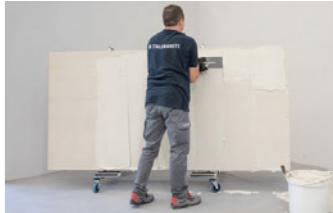
IT 4 Stendere il collante sul retro della lastra utilizzando l'apposita spatola a denti quadrati (3x3 mm) e accertarsi che le righe dell'ultima stesura siano nella stessa direzione di quelle della spalmatura della lastra. Durante la fase di stesura, la lastra dovrà essere in posizione verticale e fissata al telaio di movimento con ventose di sicurezza posate sopra al carrello per il trasporto con ruote.
