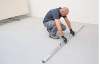
IT 1 Prima di procedere con la posa verificare che il fondo sia perfettamente planare, asciutto e pulito. Utilizzare i collanti descritti miscelati in base alle specifiche indicate nella scheda tecnica del collante prescelto. Si raccomanda l'utilizzo di adesivi cementizi ad alte prestazioni in classe C2 o superiore.
