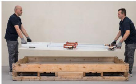
IT 3\_ Sollevare delicatamente la lastra e appoggiarla sul banco di lavoro, oppure ruotarla in posizione verticale e collocarla sul carrello di movimentazione per la stesura della colla.
